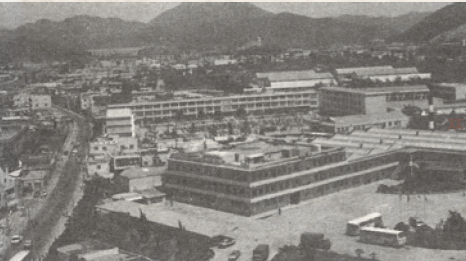
1980년대 준공업지구에 위치한 삼해공업 (현재 대림아파트 자리)
